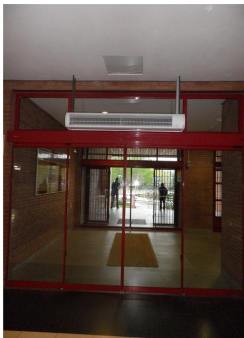
**Imagen 1.-** A la izqda., cortina de aire pasiva instalada en sótano. A la drcha., cortina de aire activa.
